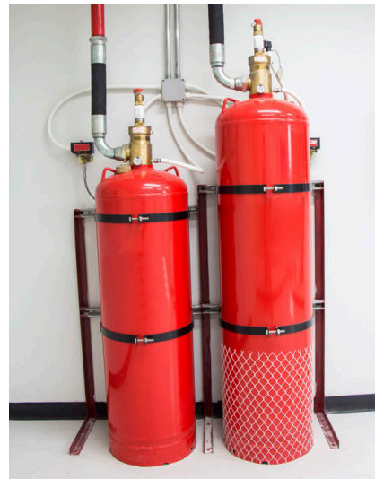
Extinction automatique à gaz
